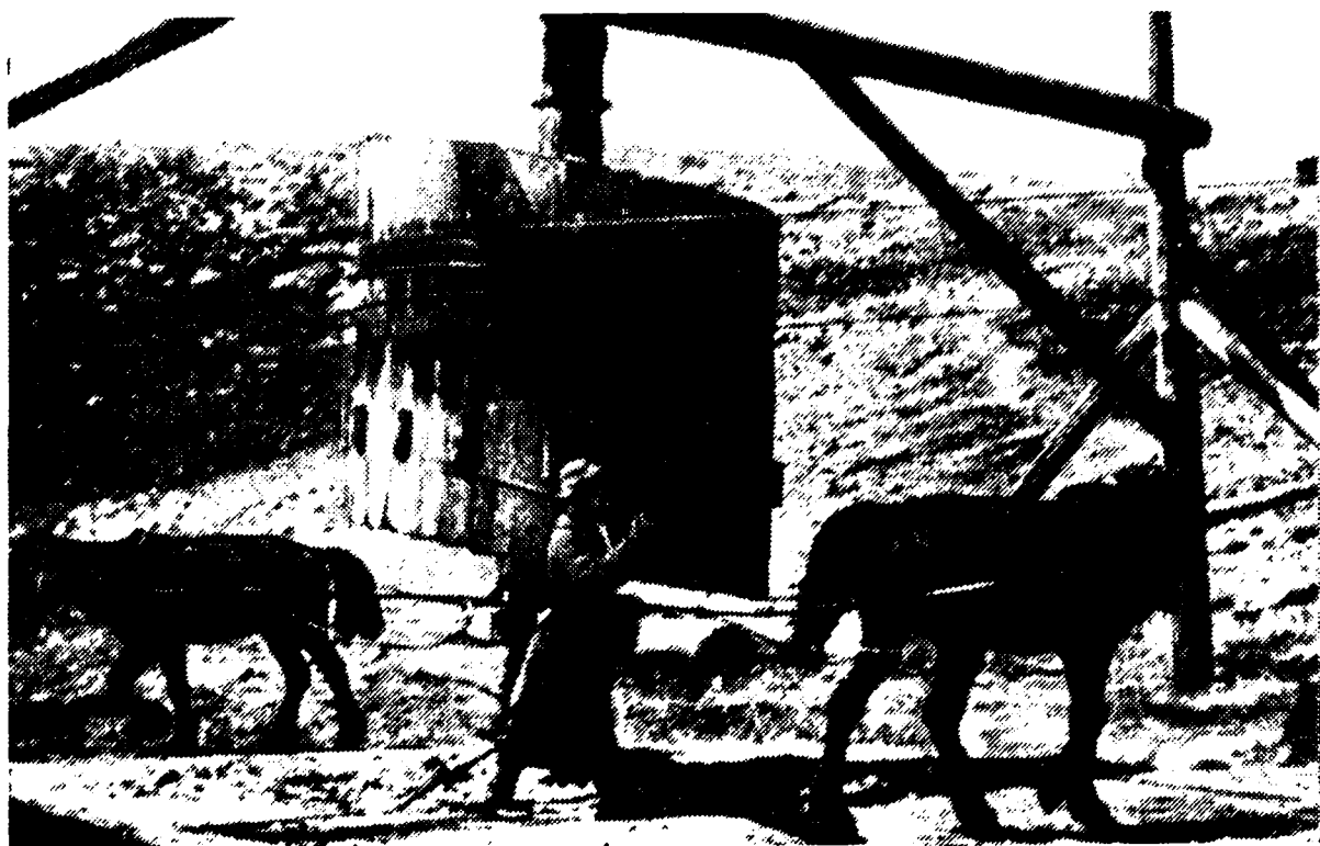
Дореволюционная Караганда. Конный вóрот для спуска людей в шахту.
